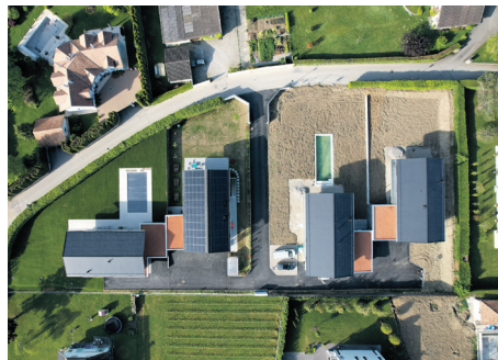
Quatre villas de standing à Mies en communauté de consommation, avec panneaux photovoltaïques sur une seule villa. Autonomie énergétique de 35%.
