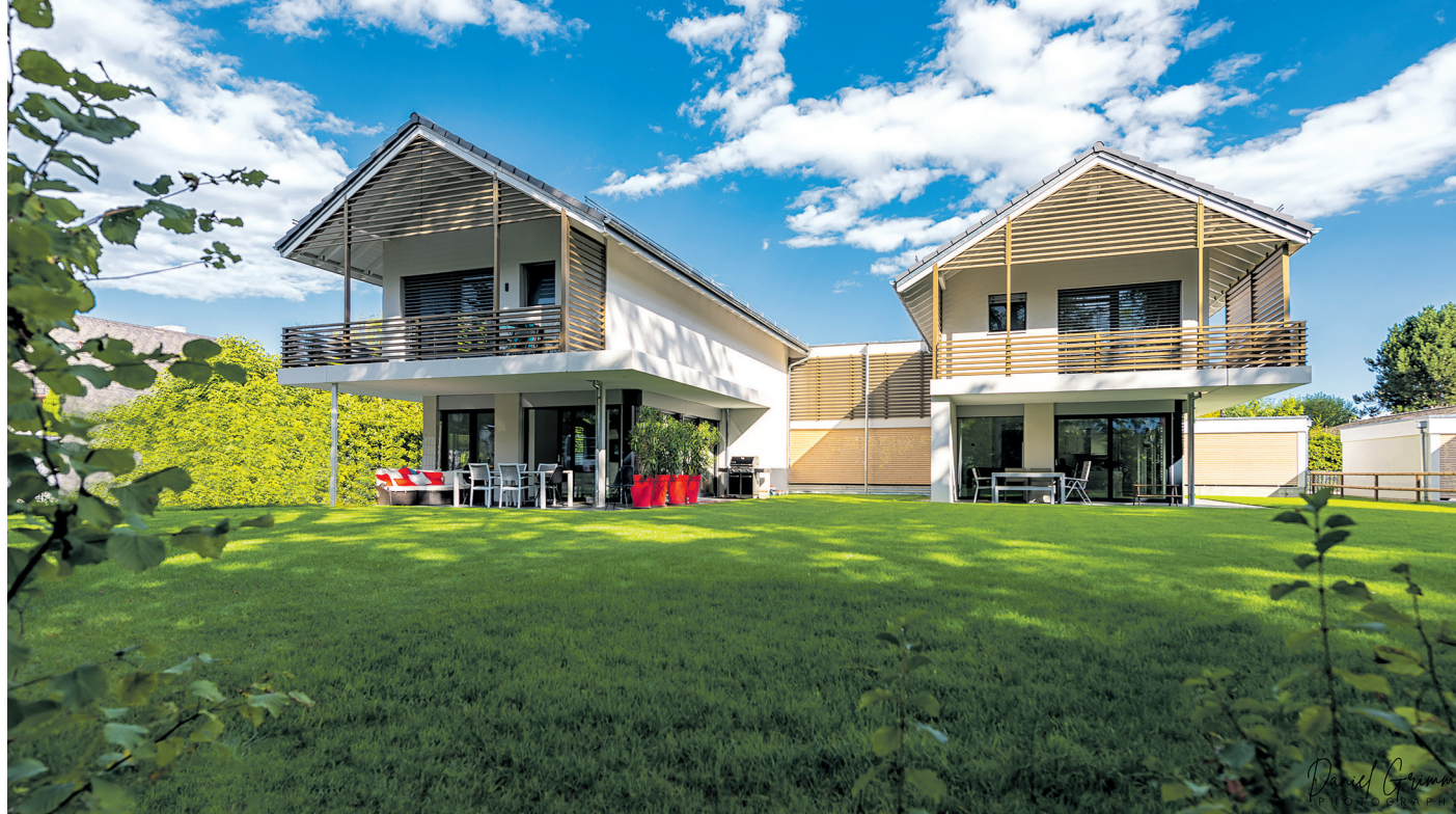
Réalisation de 4 villas à Commugny selon label CFIE
